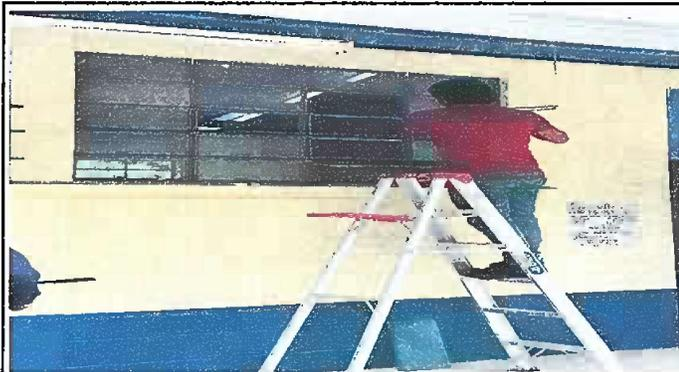
Foto 3. Modulo1: Sustitución de vidrios
