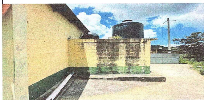
Foto 5. Pintura general: pintura en muros interiores y exteriores.
