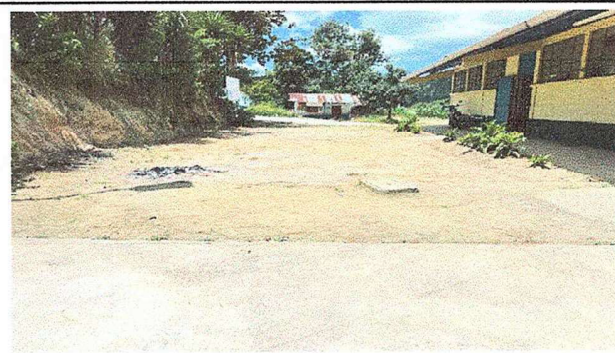
Foto 4. Patio: Reparación de piso de torta de concreto y sustitución de tubería PVC línea principal de agua pluvial.
