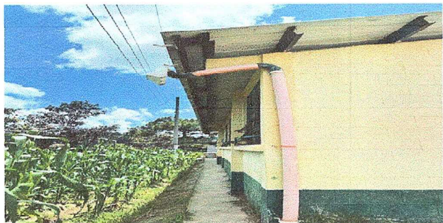
Foto 1. Modulo1: Sustitución de canales de PVC
