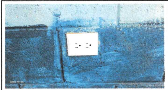
Foto 4: Modulo 1 instalando toma corrientes
