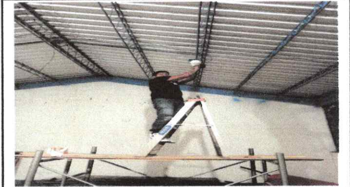
Foto 2: Modulo 1 instalando la energía electrica
