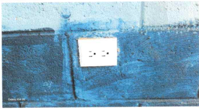
Foto 4: Modulo 1 instalando toma corrientes
