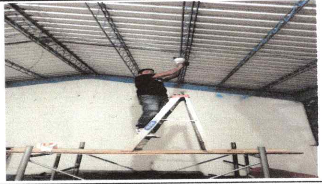
Foto 2: Modulo 1 instalando la energía electrica
