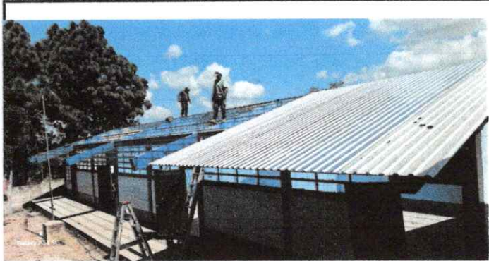
Foto1: Modulo 1 colocacion de lamina troqueladas
