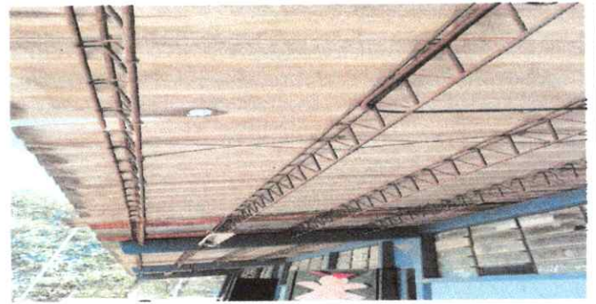
Foto 2: Modulo 1 Mantenimientos de estructura
