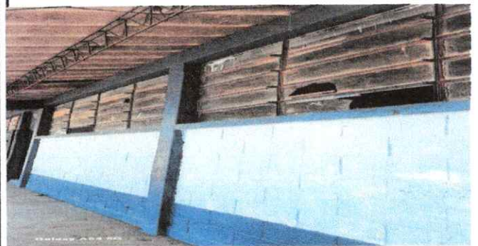
Foto 3: Modulo 1 Suministro e instalaciones de balcones
