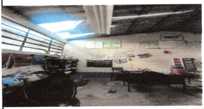
Foto 1: Modulo 1 Sustitucion de duralita por lamina troquelada alucin calibre 26
