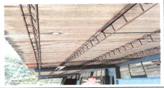
Foto 2: Modulo 1 Mantenimientos de estructura
