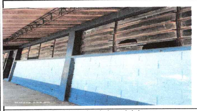
Foto 3: Modulo 1 Suministro e instalaciones de balcones
