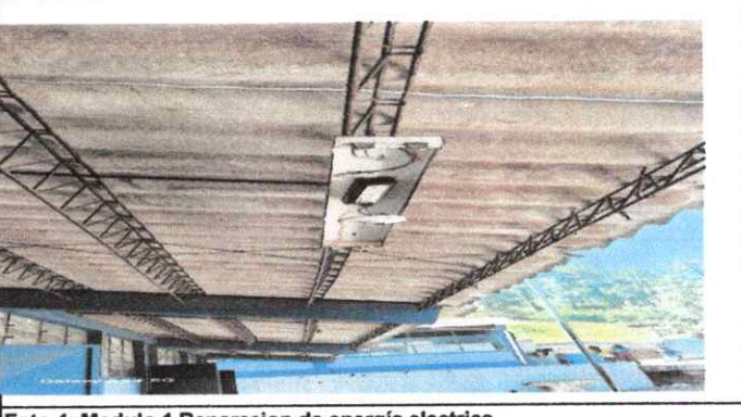
Foto 4: Modulo 1 Reparacion de energía electrica
