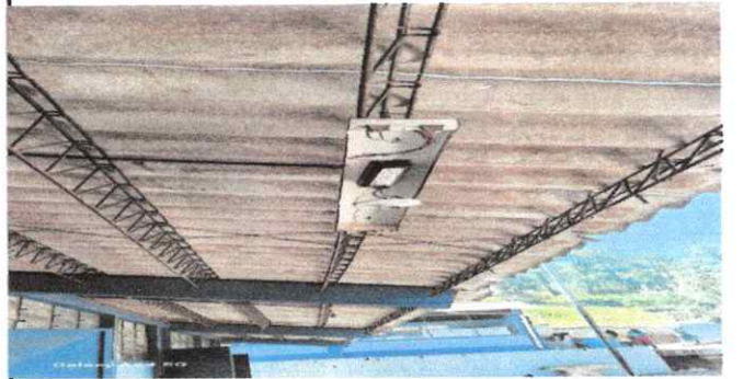
Foto 4: Modulo 1 Reparacion de energia electrica
