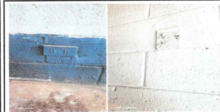
Foto 5: Modulos 1 Sustitucion de interruptores y toma corrientes
