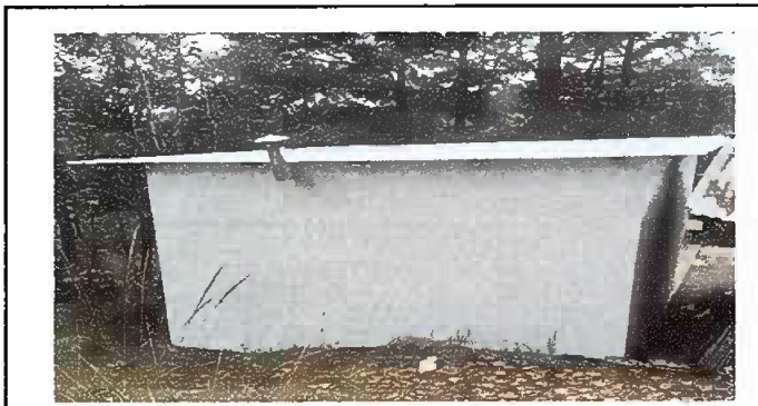
FOTO 3 MODULO 1 CERNIDO EN MURO REPELLO Y
