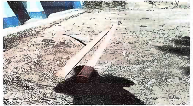
FOTO 16 MODULO 3 SUSTITUCIÓN DE TUBERÍA PVC AGUAS PLUVIALES
