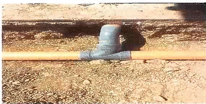
FOTO 17 MODULO 3 TUBERÍA AGUAS PLUVIALES
