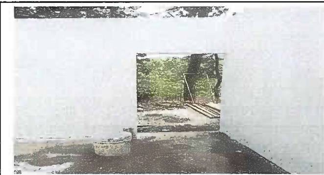
FOTO 5 MODULO 1 DE PUERTA SUSTITUCIÓN
