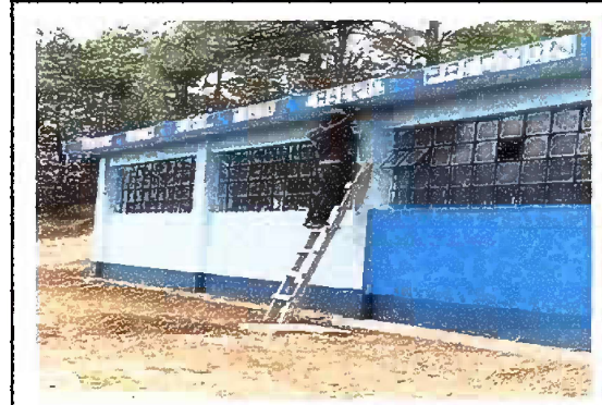
FOTO 8 MODULO 2 PINTURA DE MUROS
