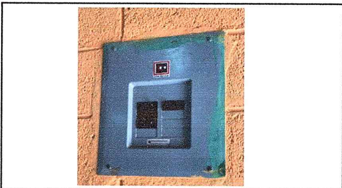
Foto 4: Sustitución de tablero de flipones
