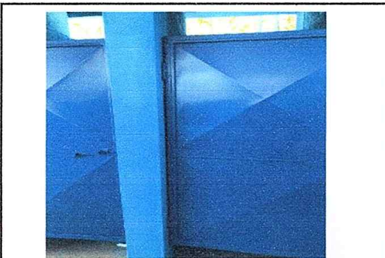
Foto 11: Mantenimiento en puertas en baños
