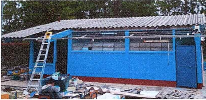
Foto 1: Sustitución de lámina a lámina troquelada aluzinc, calibre 26
