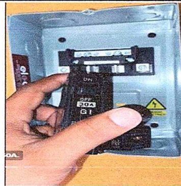
Foto 4: Sustitución de tablero de flipones
