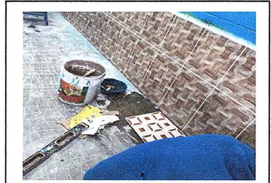
Foto 8: Suministro e instalación de azulejo en cocina
