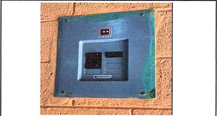
Foto 4: Sustitución de tablero de flipones
