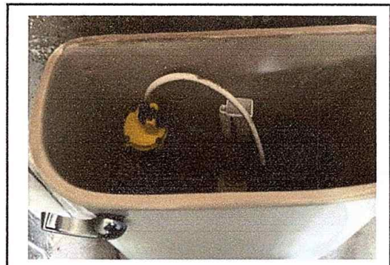
Foto 12: Sustrucción de accesorios de inodoros
