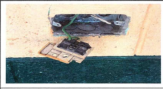
Foto 5: Sustitución de interruptores dobles
