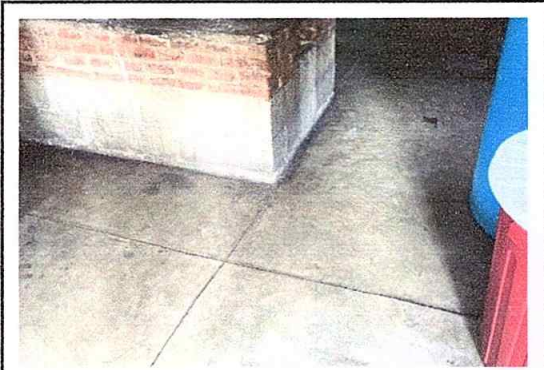
Foto 7: Sustrucción de piso de torta de concreto por piso cerámico
