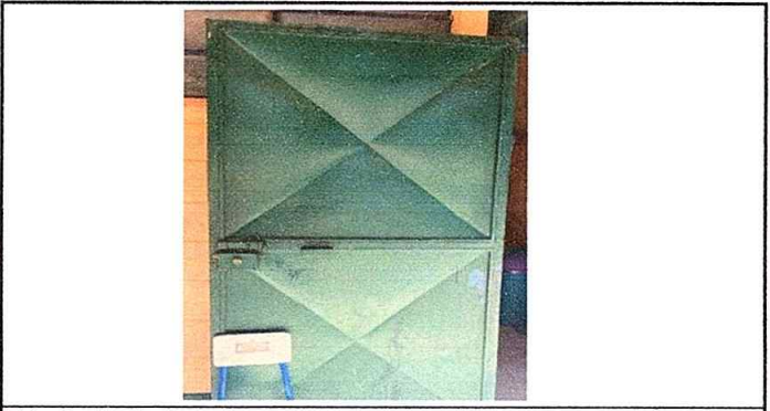
Foto 6: Mantenimiento a estructura de puerta
