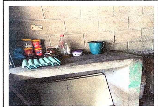
Foto 8: Suministro e instalación de azulejo en cocina
