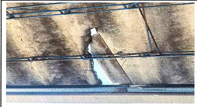
Foto 1: Sustitución de lámina a lámina troquelada aluzinc, calibre 26
