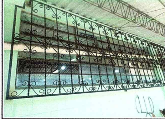
Foto 2: Mantenimiento de balcones de metal
