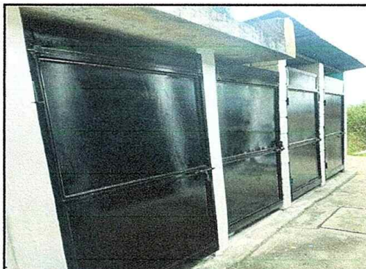
Foto 4: Mantenimiento a estructura de puerta (lijado, cambio de tubo, cepillado, sujeciones, aplicación de pintura)
