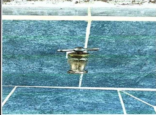
Foto 13: sustitucion de llave de chorro.
