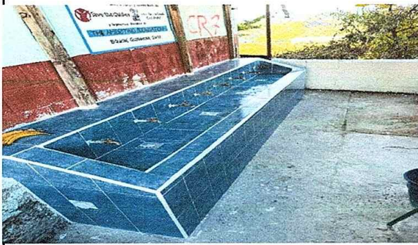
Foto 9: Sustitucion de azulejo
