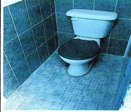
Foto 14: sustitucion de piso en baños
