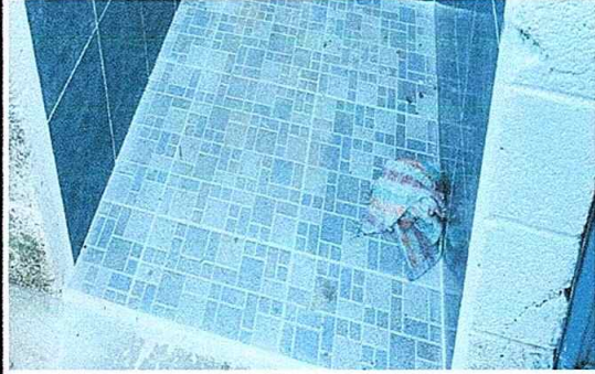
Foto 8: Sustitución de piso
