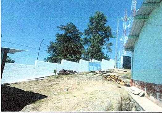
Foto 7: Pintura muro perimetral
