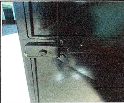
Foto 11: sustitución de chapa
