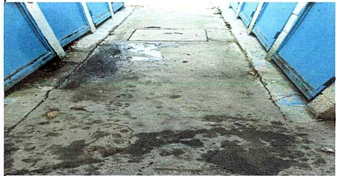
Foto 8: Sustitución de piso
