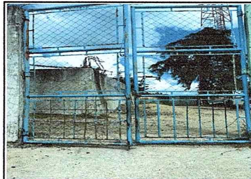
Foto 12: fabricacion e instalacion de porton de metal de ingreso
