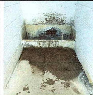
Foto 10: sustitucion de azulejo e instalacion de piso
