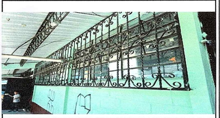
Foto 2: Mantenimiento de balcones de metal
