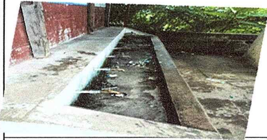
Foto 9: Sustitucion de azulejo
