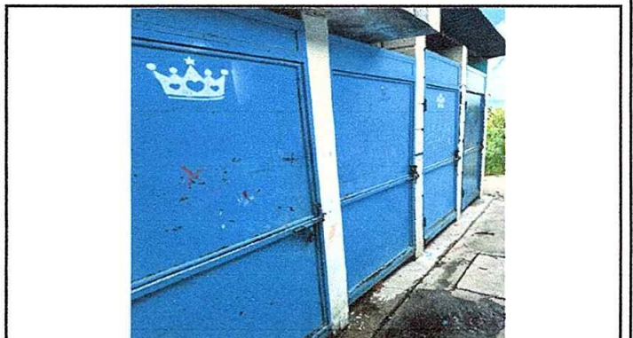
Foto 4: Mantenimiento a estructura de puerta (lijado, cambio de tubo, cepillado, sujeciones, aplicación de pintura)
