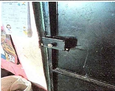
Foto 11: sustitución de chapa
