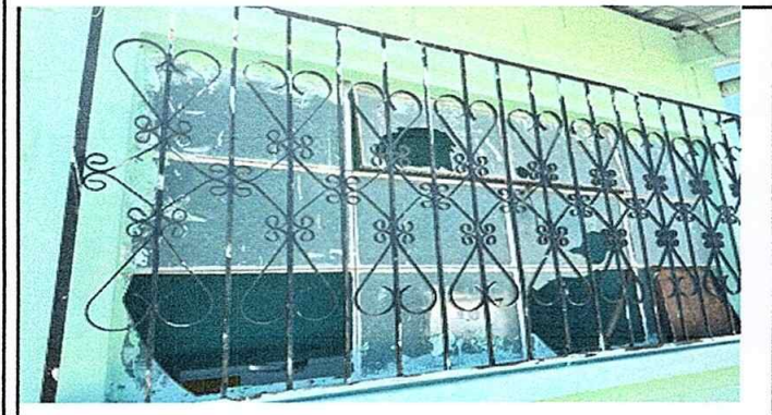
Foto 3: Sustitución de vidrios
