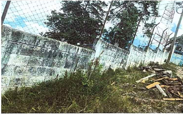
Foto 7: Pintura muro perimetral
