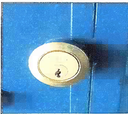
Foto 11: MODULO 2: Instalacion de Chapa
