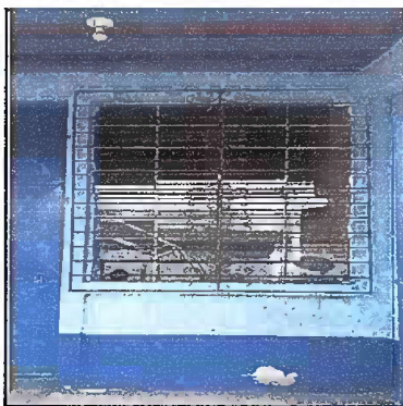
Foto 5: MODULO 1: Mantenimiento de Balcones de Metal
