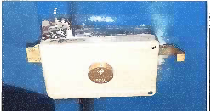
Foto 10: MODULO 2: Instalacion de Chapa
