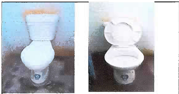
Foto 11: MODULO 5: Instalacion de Inodoros
