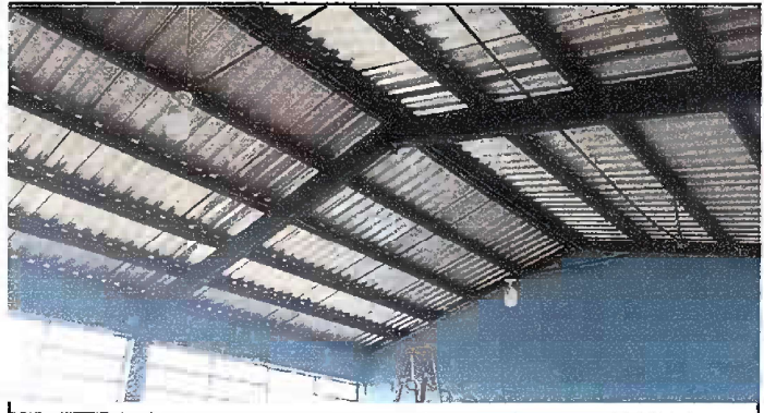
Foto 4: MODULO 1: Instalacion de plafoneras
