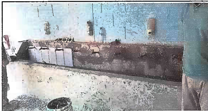
MODULO 17: Sustitución de Chorros , sustitución de Azulejo
