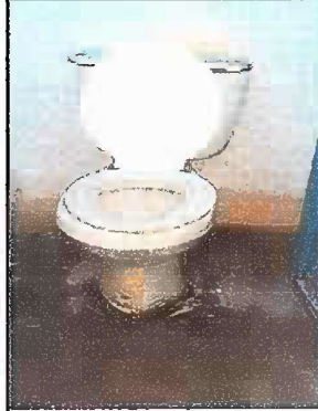
Foto 14: MODULO 5: Sustitucion de Sanitarios
