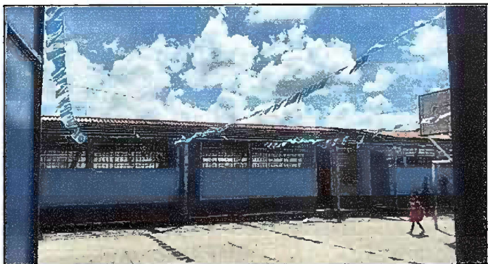
Foto 3: MODULO 1: Desinstalacion de Laminas
