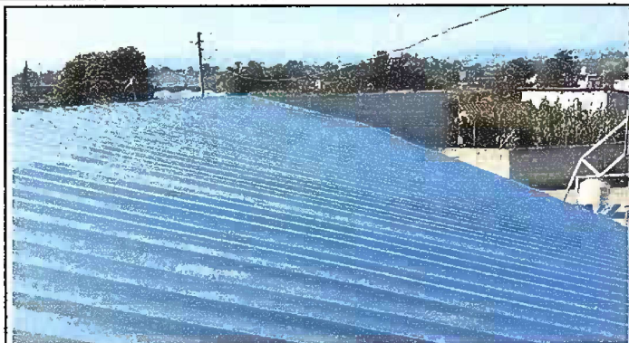
Foto 1: MODULO 1 : Sustitucion de Capotes para Lamina Troquelada
