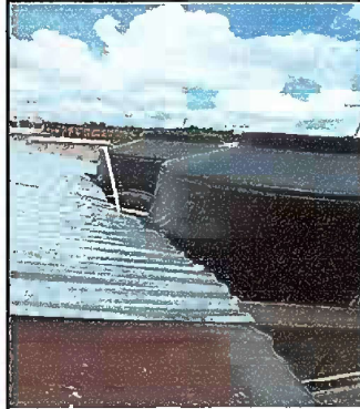
MODULO 16: Sustitucion de accesorios de deposito de agua
