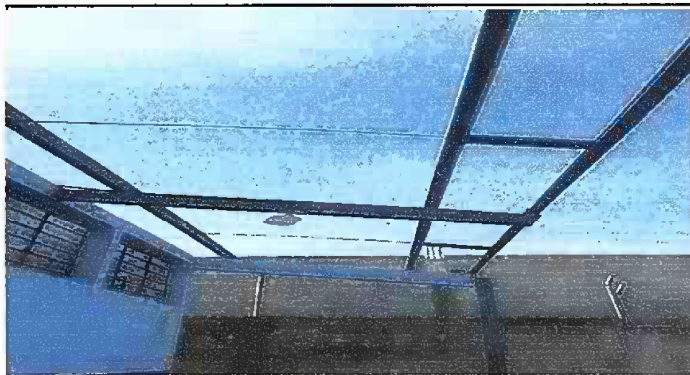
Foto 4: MODULO 1: Desinstalacion de Canales de Pvc
