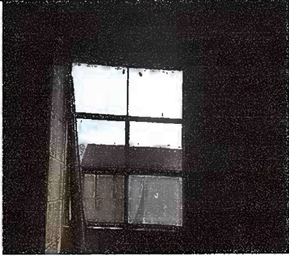
Foto 13: MODULO 4: Sustitucion de Vidrios
