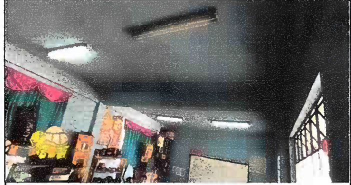
Foto 8: MODULO 2: Sustitucion de Focos Ahorradores
