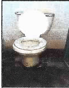
Foto 14: MODULO 5: Sustitucion de Sanitarios
