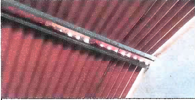
Foto 1: MODULO 1 : Sustitucion de Capotes para Lamina Troquelada
