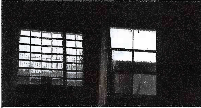
Foto 13: MODULO 4: Sustitucion de Vidrios
