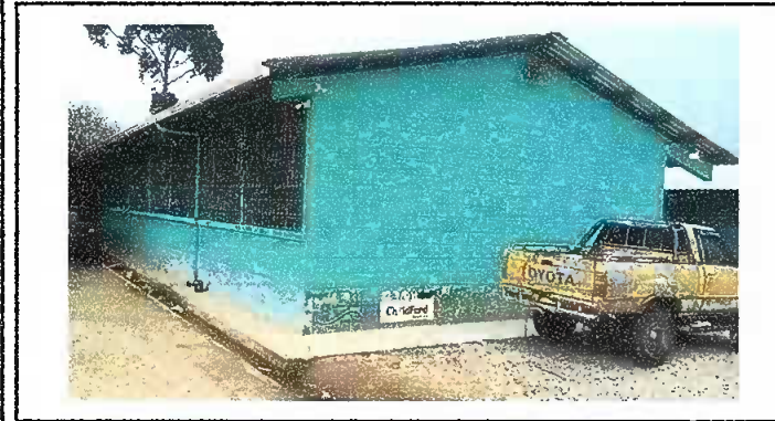
Módulo 1: Pintura en muros exteriores e interiores.
