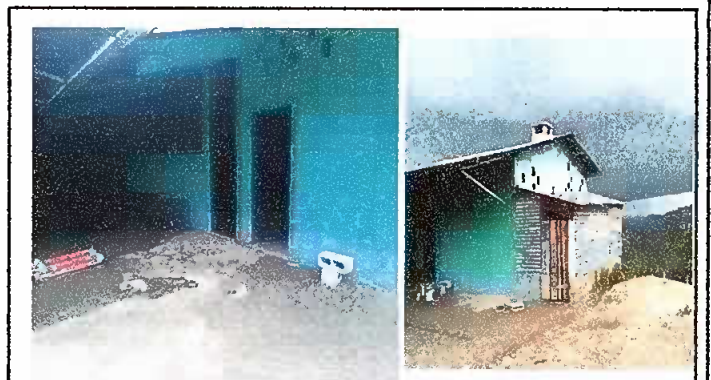
Módulo 2: Pintura en muros exteriores e interiores.
