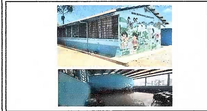
Módulo 1: Pintura en muros exteriores e interiores.
