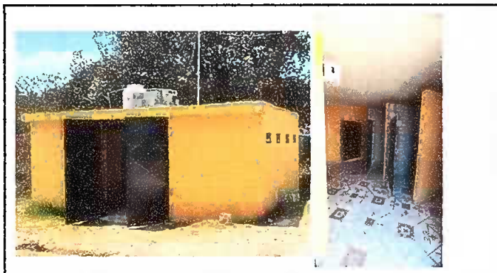
Módulo 4: Pintura en muros exteriores e interiores.
