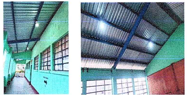
Foto 4: Modulo 1 . Sustitución de lámparas
