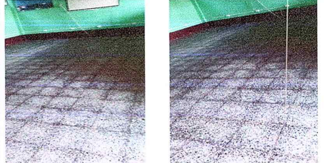
Foto 2: Sustitucion de piso de torta de concreto en aulas
