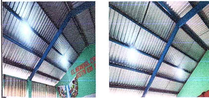
Foto 3: Modulo 1. Reparación de cableado Eléctrico
