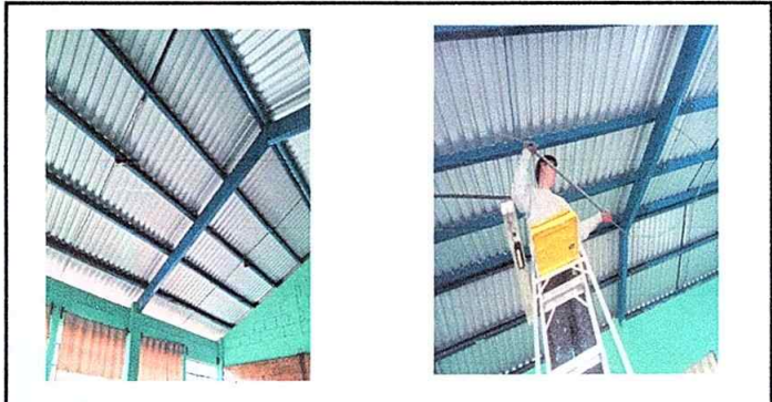
Foto 6: Sustitucion de cableado eléctrico
