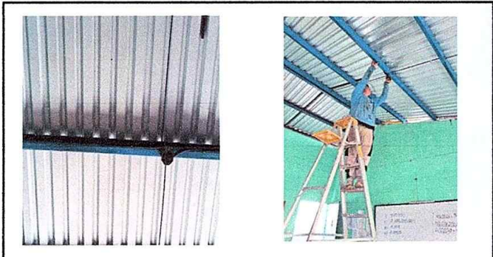
Foto 5: Sustitución de lámparas
