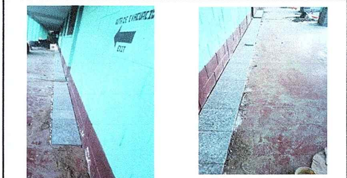
Foto 2: Sustitucion de piso de torta de concreto en el pasillo
