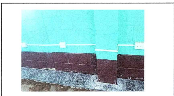
Foto 3: Sustitucion de piso de torta de concreto en las aulas.
