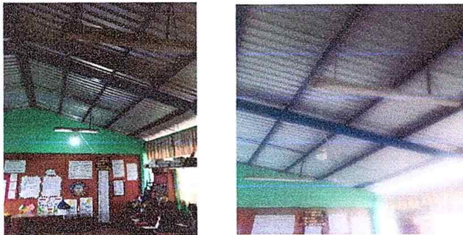
Foto 3: Modulo 1, Sustitución de lámparas
