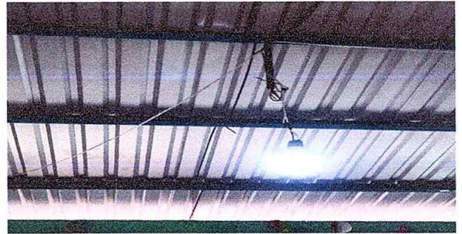
Foto 2: MODULO 1 Reparación de Cableado Electrico
