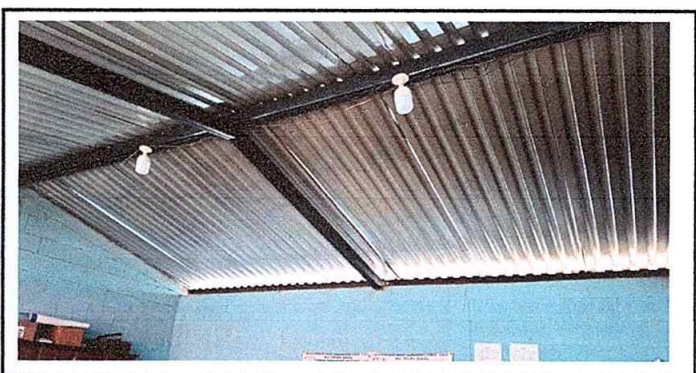
Foto 18: modulo 4 sustitucion de lamparas
