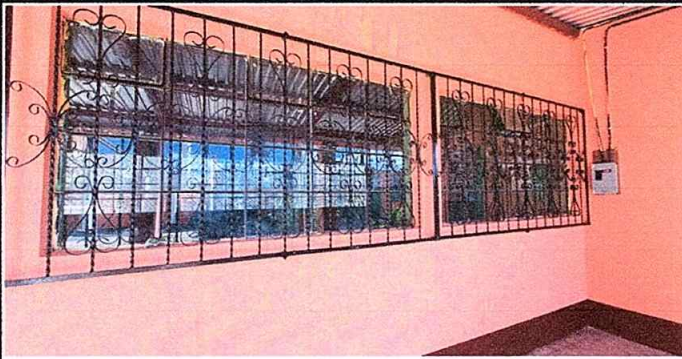
Foto 11: MODULO 3 sustitucion de vidrios
