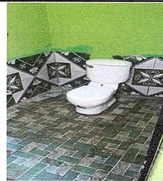
Foto 12: MODULO 3 sustitucion de sanitario
