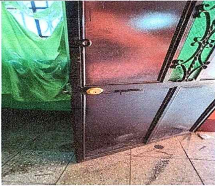
Foto 7: MODULO 2 sustitucion de chapa
