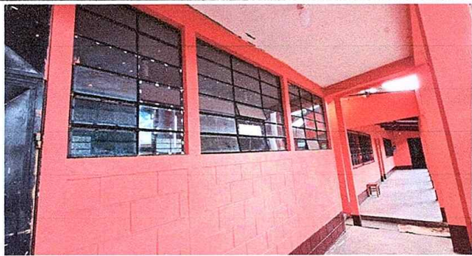
Foto 3: MODULO 1 Se sustituyeron los vidrios
