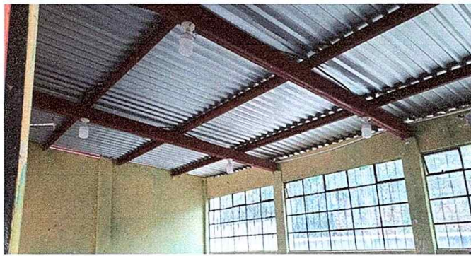
Foto 9: MODULO 2 sustitucion de focos ahorradores
