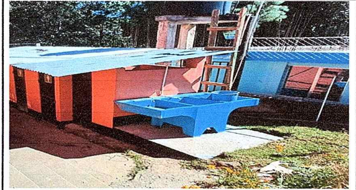
Foto 14:MODULO 3 Se realizó la instalacion de pila
