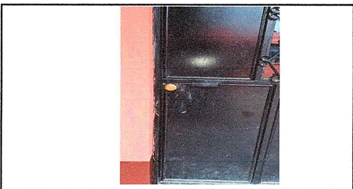
Foto 17: modulo 4 sustitucion de chapas
