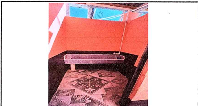
Foto 16: modulo 3 colocacion de azulejo al mingitorio
