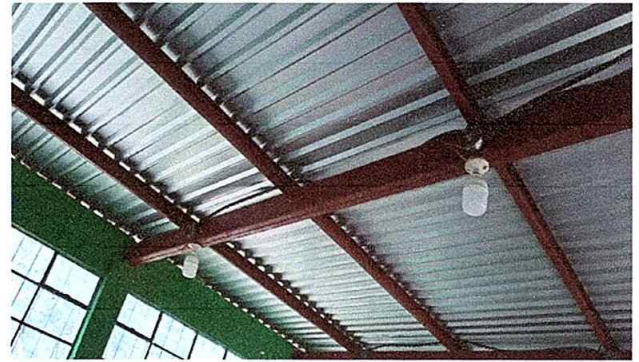
Foto 9: MODULO 2 sustitucion de plafoneras
