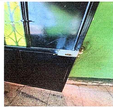
Foto 8: MODULO 2 sustitucion de chapa
