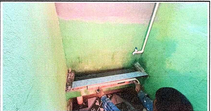
Foto 16: modulo 3 colocacion de azulejo al mingitorio
