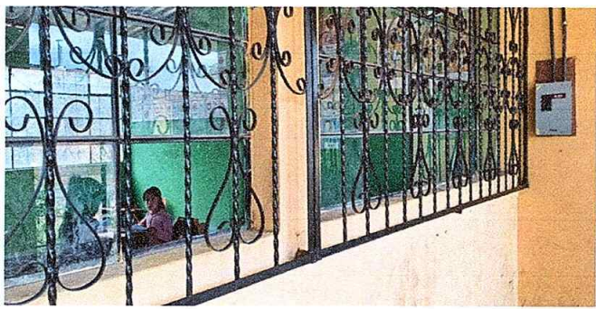
Foto 11: MODULO 3 sustitución de vidrios
