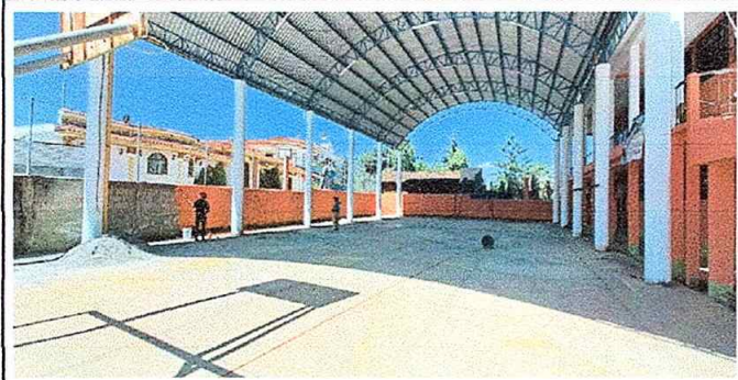
Foto 21: PINTURA GENERAL trabajos de pintura en muros exteriores
