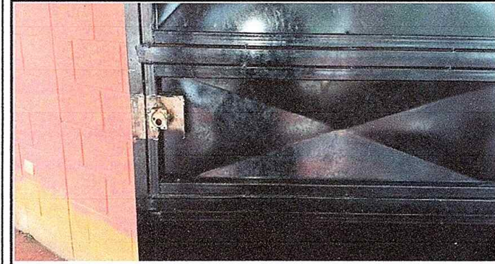
Foto1: MODULO 1 se muestra el trabajo de sustitucion de chapa
