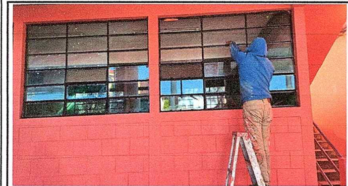
Foto 3: MODULO 1 trabajo de sustitucion de vidrios
