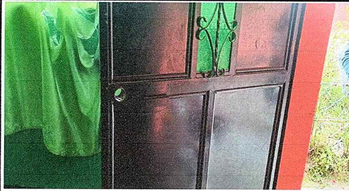
Foto 7: MODULO 2 Trabajo de sustitucion de chapa
