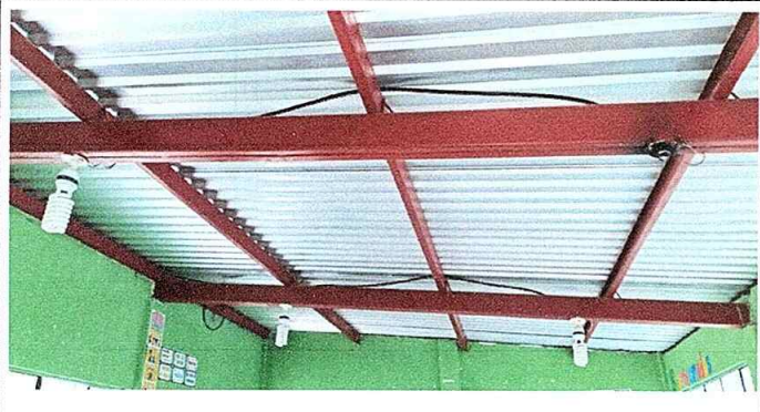
Foto 9: MODULO 2 sustitución de focos ahorradores
