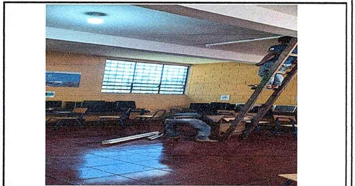
Foto 4: MODULO 1 cambio de lamparas por focos ahorradores tipo led
