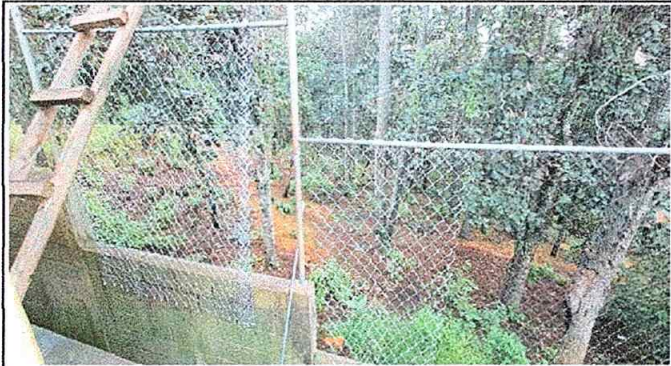
Foto 19: MURO PERIMETRAL sustitucion y reparacion de la malla que circula el establecimiento
