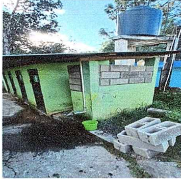
Foto 13: MODULO 3 trabajos en mingitorio
