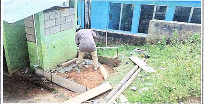
Foto 14: MODULO 3 trabajos para instalacion de pila
