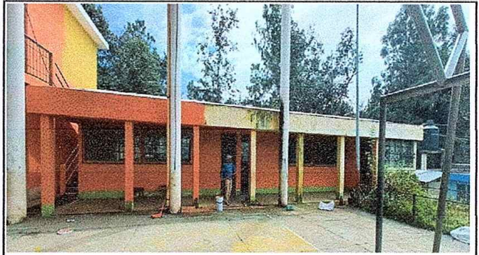
Foto 20: PINTURA GENERAL trabajos de pintura en muros exteriores
