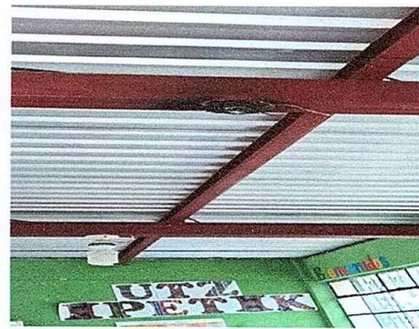
Foto 9: MODULO 2 sustitucion de plafoneras
