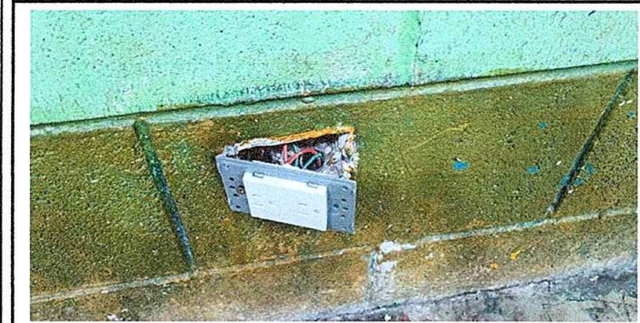
Foto 5: MODULO 1sustitucion de tomacorriente doble
