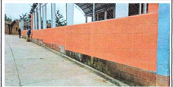
Foto 22: PINTURA GENERAL trabajos de pintura en muros exteriores
