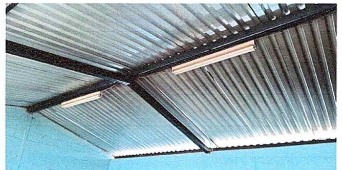
Foto 18: MODULO 4 sustitucion de lamparas por focos tipo led
