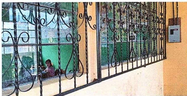
Foto 11: MODULO 3 sustitución de vidrios
