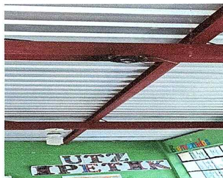
Foto 9: MODULO 2 sustitucion de plafoneras
