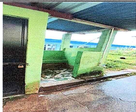
Foto 16: modulo 3 se colocara azulejo a la orilla del mingitorio
