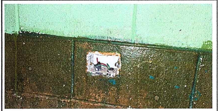
Foto 6: MODULO 1sustitucion de tomacorriente doble
