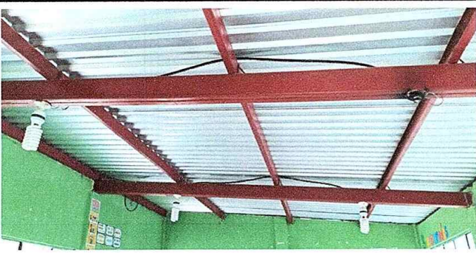
Foto 9: MODULO 2 sustitución de focos ahorradores
