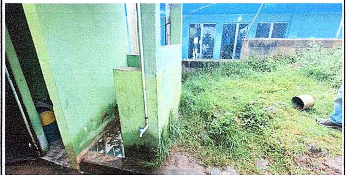
Foto 14: MODULO 3 instalacion de pila
