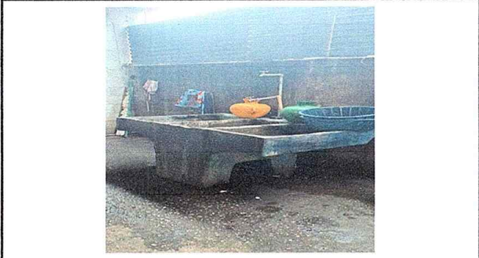
Foto19: MODULO 4 sustitucion de pila
