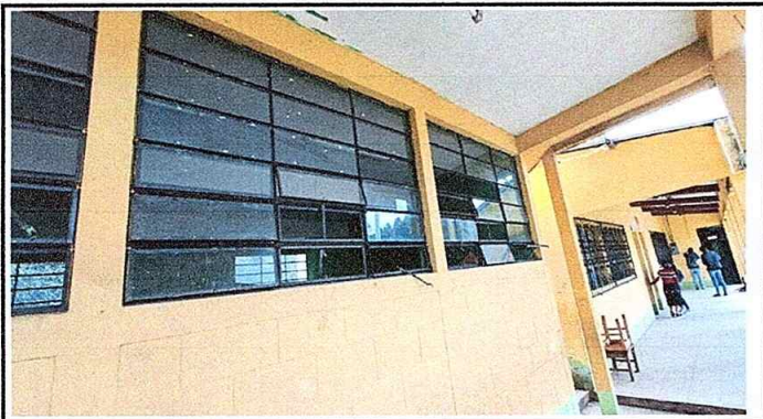
Foto 3: MODULO 1 se muestra las ventanas donde se sustituiran los vidrios
