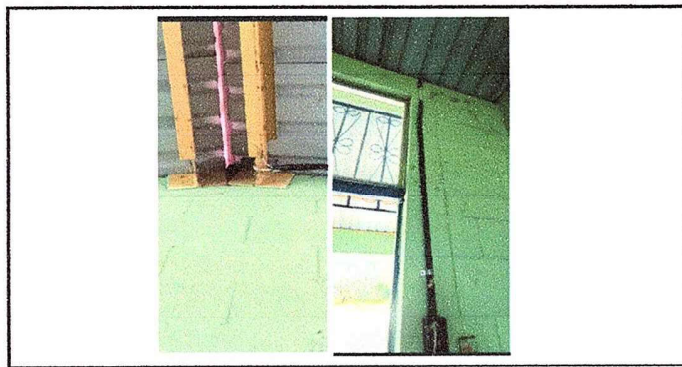
Foto 17 Modulo 3: Reparación de cableado eléctrico
