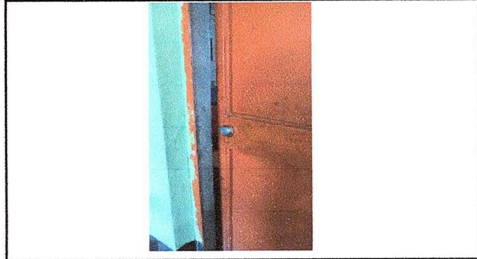
Foto 20 Modulo 3: Sustitucion de chapa
