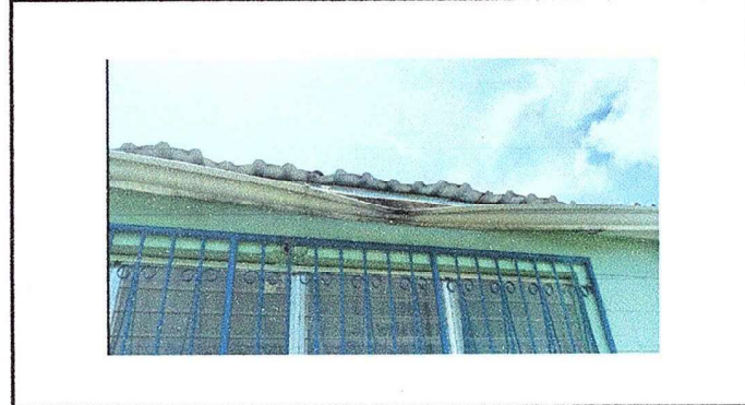
Foto 22 Modulo 3: Sustitución de canal de pvc
