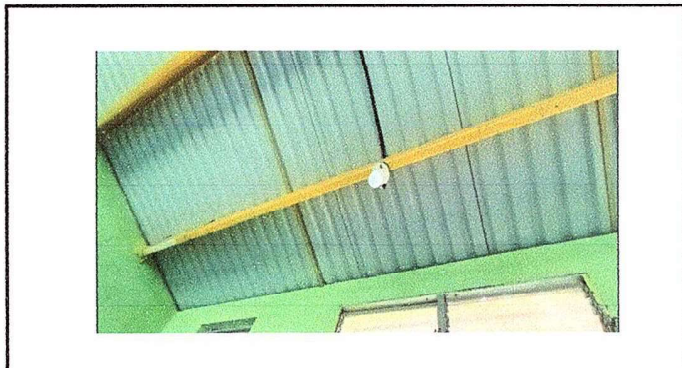
Foto 15 Modulo 3: Sustrucción de lámparas tipo led e instalación de unidades de luz (incluye interruptor y cable eléctrico)
