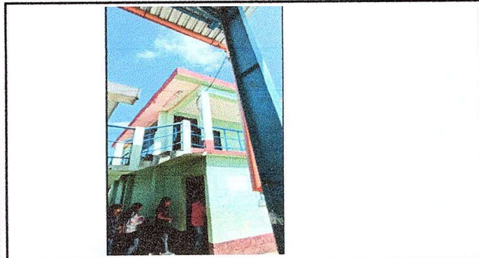
Foto 25 Modulo 4: Pintura en muros exteriores
