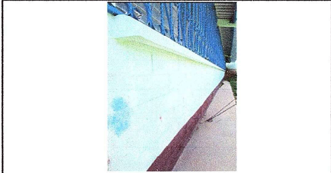
Foto 1 Modulo 1: Pintura en muros exteriores
