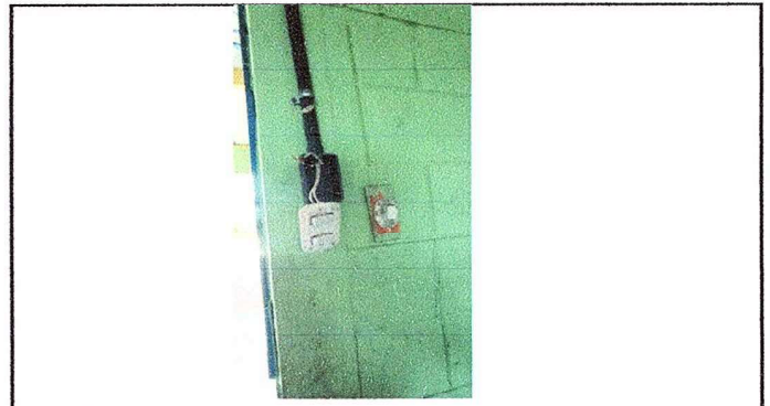
Foto 16 Modulo 3: Sustrucción interruptores dobles
