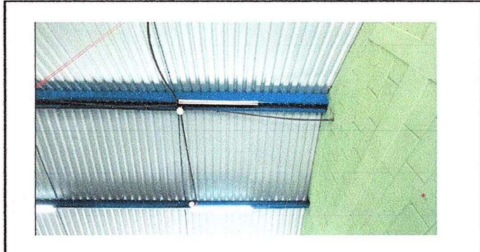
foto 4 Modulo 1: Reparacion de cableado electrico
