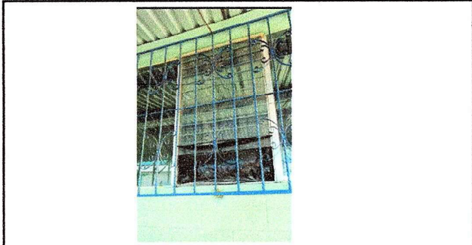
Foto 7 Modulo 1: Stitucion de vidrios
