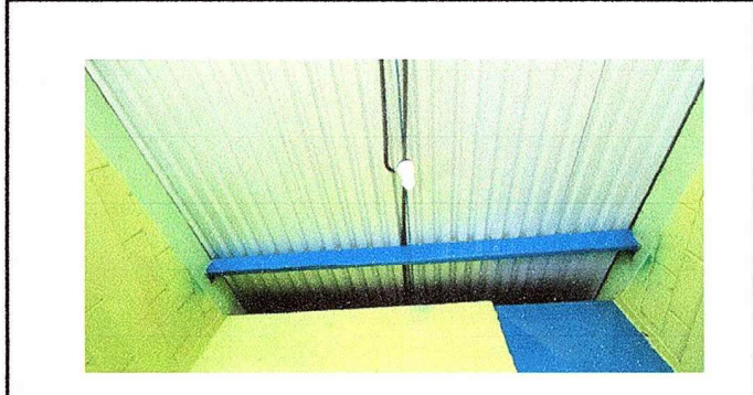
Foto 2 Modulo 1: Sustitucion de lamparas tipo led e Instalación de unidades luz (incluye interruptor y cable eléctrico)
