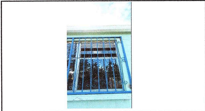
Foto 19 Modulo 3: Sustitucion de vidrios
