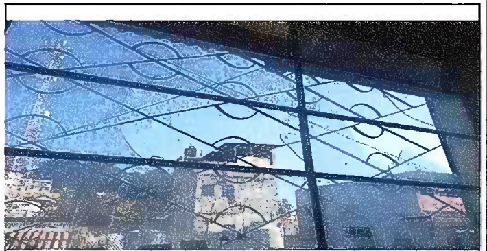
Foto 6: MODULO 2 SUSTITUCION DE VIDRIOS
