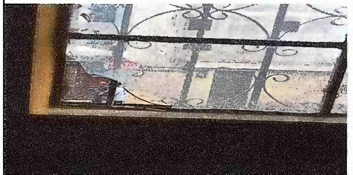
Foto 4: MODULO 3 SUSTITUCION DE VIDRIOS
