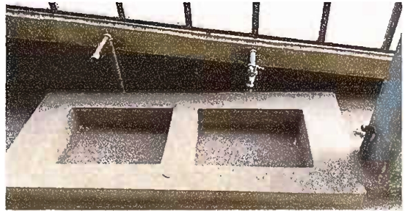
Foto 2: MODULO 3 SUSTITUCION DE LLAVE DE CHORRO
