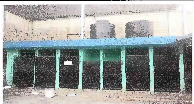
Foto 2: MODULO 7 SUSTITUCION DE ACCESORIO DE DEPOSITOS DE AGUA, PINTURA, SUSTITUCION DE TUBERIA PRINCIPAL, MANTENIMIENTO DE ESTRUCTURA
