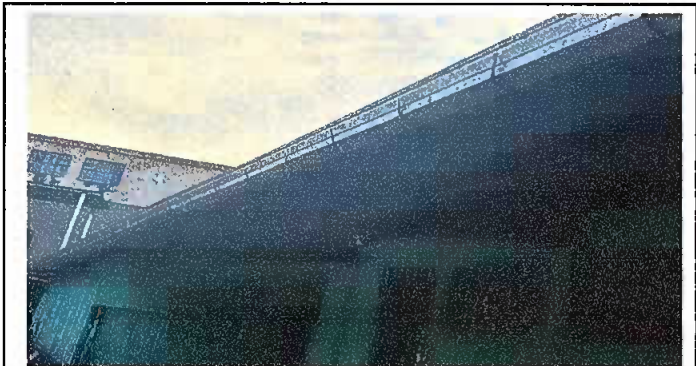
Foto 5: MÓDULO 5 SUSTITUCION DE SOPORTE O PESCANTE DE METAL PARA CANAL
