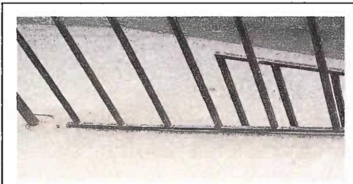
Foto 6: MODULO 4 MANTENIMIENTO A BARANDAS
