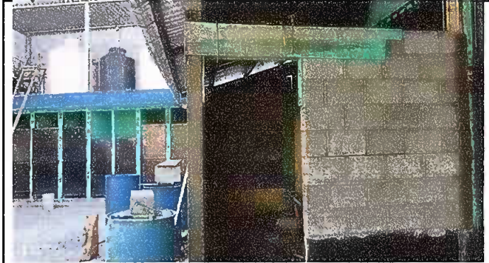
Foto 2: MODULO 6 REPARACION DE MURO PERIMETRAL.
