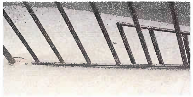
Foto 6: MODULO 4 MANTENIMIENTO A BARANDAS
