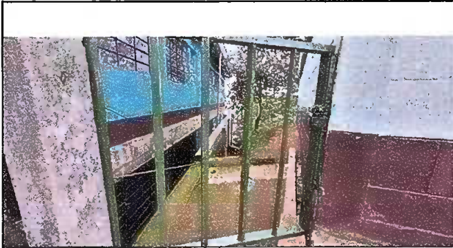
Foto 7: Instalación de baranda
