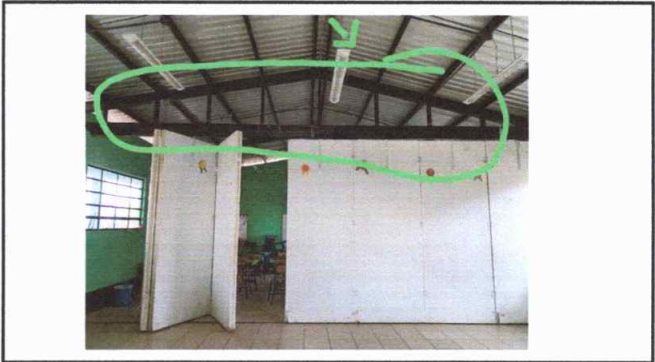
Foto 10: Suministro e Instalación de muro de plywood
