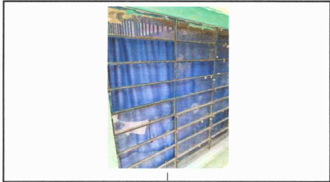
Foto 2: Fabricación e instalación de balcones de hierro en ventana
