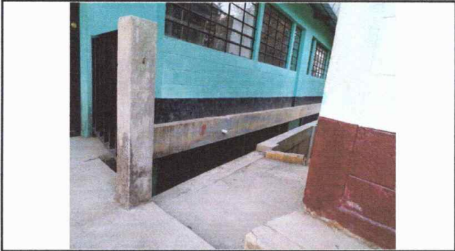
Foto7: Instalación de baranda
