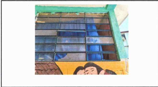
Foto 3: Sustitución de vidrios
