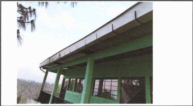
Foto 9: Sustitución de bajada de agua pluvial de metal por tubo PVC 3"
