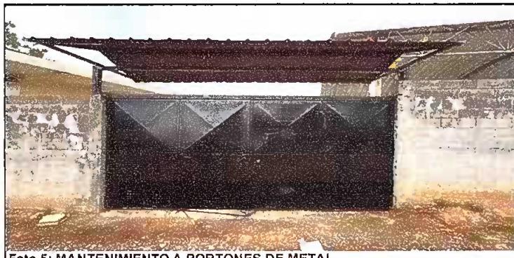
Foto 5: MANTENIMIENTO A PORTONES DE METAL
