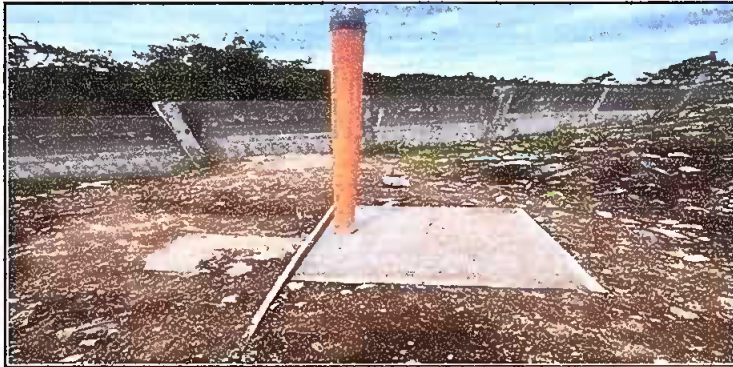
Foto1: SUSTITUCION DE FOSA SEPTICA POR BIODIGESTOR
