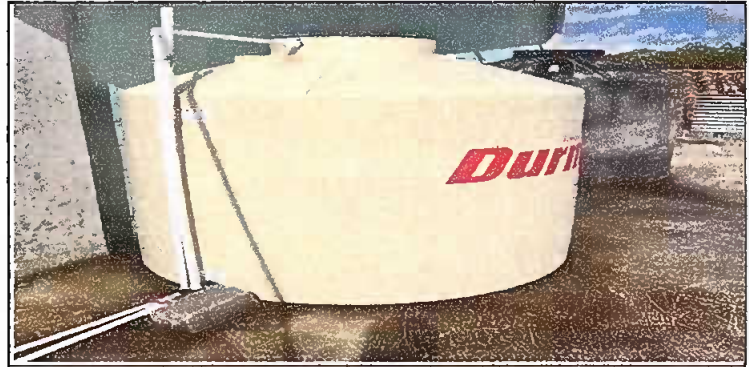
Foto 2: SUSTITUCION DE DEPOSITO DE AGUA
