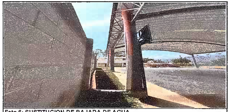
Foto 6: SUSTITUCION DE BAJADA DE AGUA
