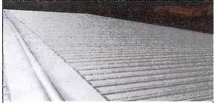
Foto 2: SUSTITUCION DE CAPOTE DE LAMINA PARA LAMINA TROQUELADA
