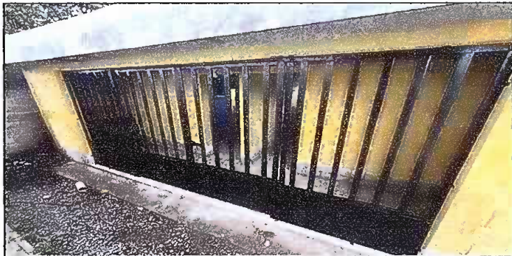
Foto 3: FABRICACION E INSTALACION DE PUERTA DE REJAS
