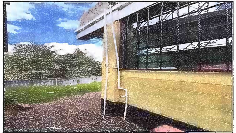
Foto 4: SUSTITUCION DE CANAL PVC (INCLUYE PESCANTE, TAPADERAS, BAJADAS Y UNIONES)
