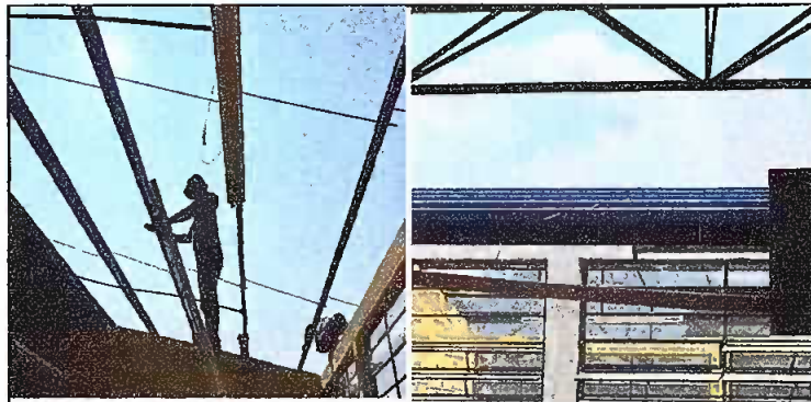
Foto 3: MANTENIMIENTO A LAS ESTRUCTURAS DE SOPORTE DE METAL
