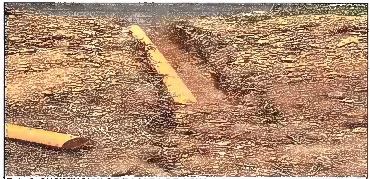
Foto 6: SUSTITUCION DE BAJADA DE AGUA
