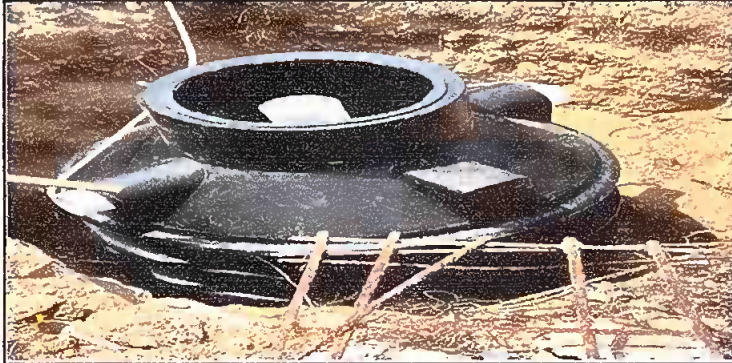
Foto1: SUSTITUCION DE FOSA SEPTICA POR BIODIGESTOR
