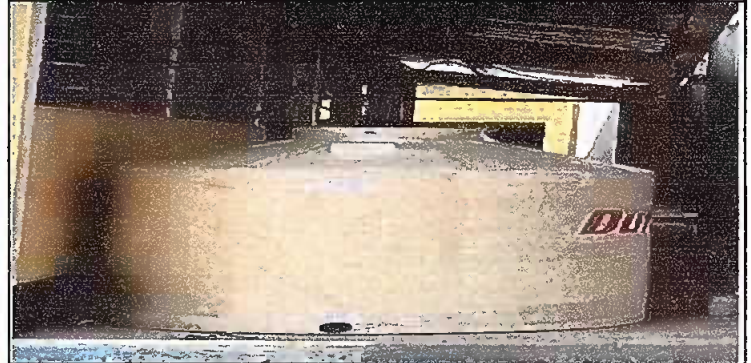
Foto 2: SUSTITUCION DE DEPOSITO DE AGUA
