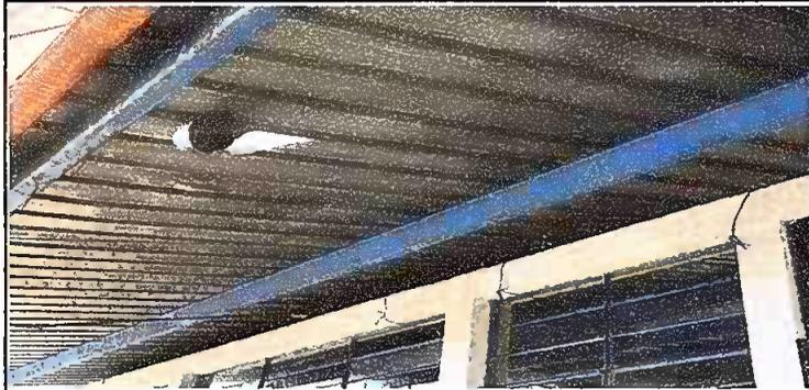
Foto1: SUSTITUCION DE LAMINA TROQUELADA ALUZINC CALIBRE 26
