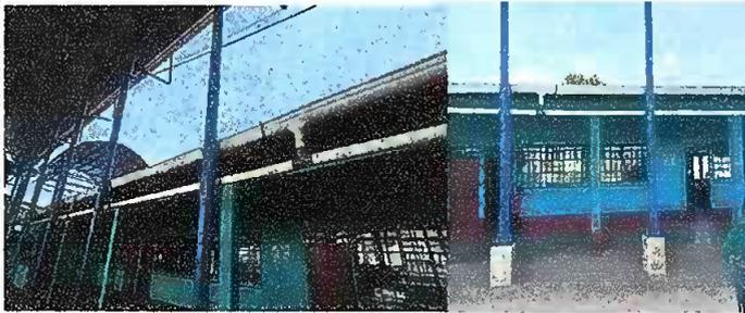
**Modulo 3: Sustitución de canal de pvc, sustitucion de bajada de agua pluvial de metal por tubo pvc 3".**
