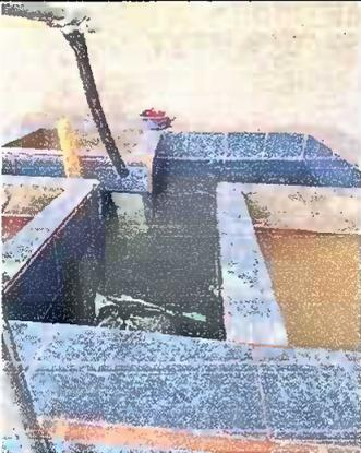
Foto93: Sustrucción de pila por pila in situ
