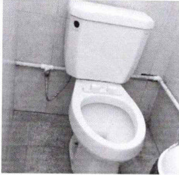
Foto7: Sustitución de inodoro
