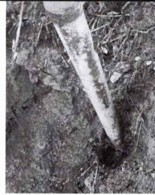
Foto 4: MODULO 3. Sustitución de tubería PVC Lineal principal aguas negras
