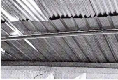
Foto1: MODULO 1. Mantenimiento de estructura metal
