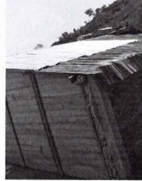
Foto 2: Sustitución de lámina por lámina troquelada aluzinc calibre 26
