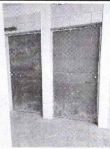
Foto 5: MODULO 4. Sustitución de puerta
