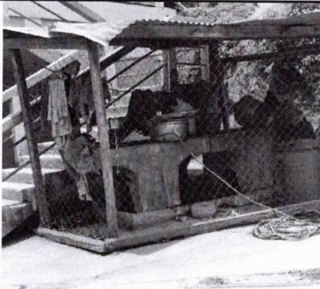
Foto 9: Sustitución de pila por pila in situ
