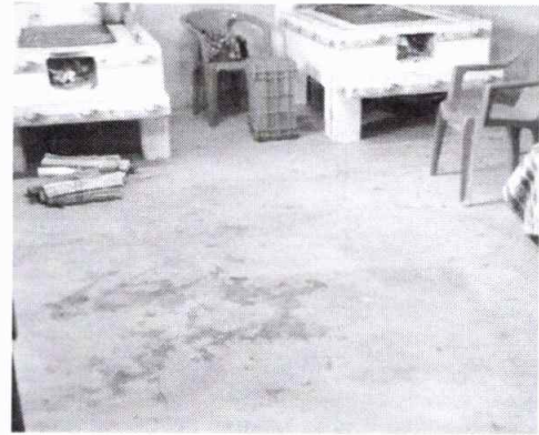
Foto 10: Reparación de piso cerámico
