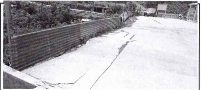
Foto 12: Reparación de planchas de concreto de piso
