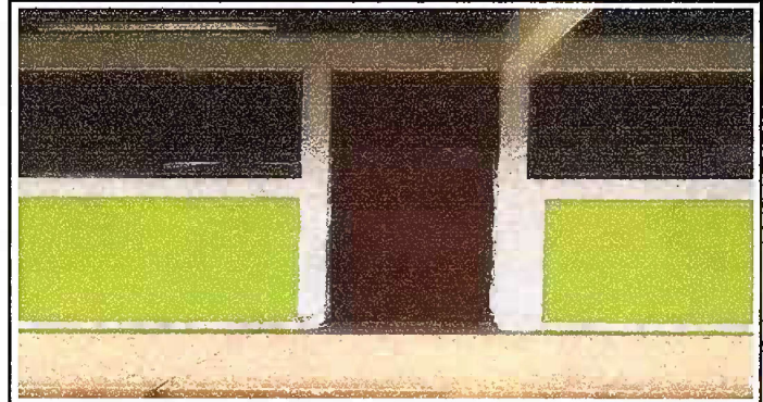
Módulo 1: Mantenimiento a estructura de puerta (lijado, cambio de tubo, cepillado, sujetiones, aplicación de pintura)
