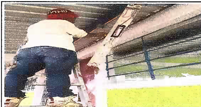
Módulo 2: Sustitución de lamparas tipo LED
