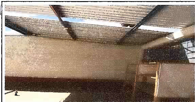
Módulo 2: Sustitución de lámina por lámina troquelada
