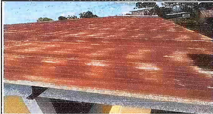
Módulo 1: Sustitución de lámina por lámina troquelada
