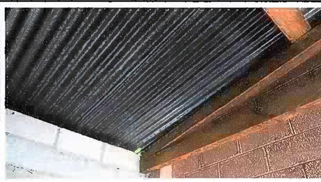
Foto 4: Módulo 1, sustitución de estructura de soporte de madera, por metal.
