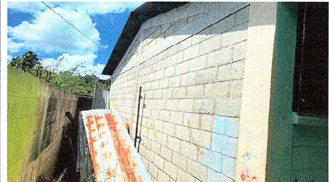
Foto 2: Módulo 1, sustitución de lámina, por lámina troquelada aluzinc calibre 26.
