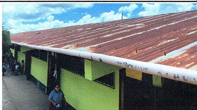
Foto 3: Módulo 1, sustitución de lámina, por lámina troquelada aluzinc calibre 26.
