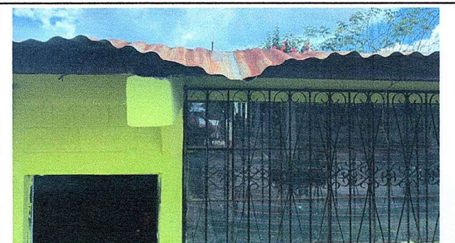
Foto 5: Módulo 2, sustitución de lámina, por lámina troquelada aluzinc calibre 26
