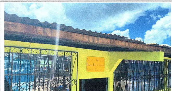
Foto 6: Módulo 2, sustitución de estructura de soporte de metal, por metal.
