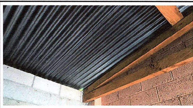
Foto 4: Módulo 1, sustitución de estructura de soporte de madera, por metal.
