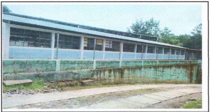
Foto 6: Muro Perimetral: Reparación de muro perimetral de block con tubo HG y malla galvanizada, solera intermedia y columnas.
