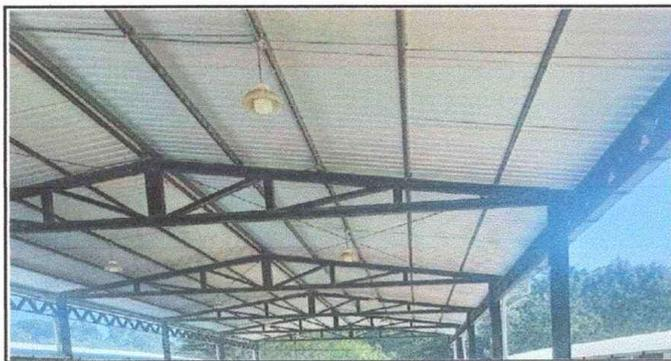
Foto 5: Cancha: Sustitución de canal de metal
