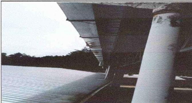
Foto 3: Modulo 2 Sustitución de canal de metal
