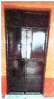
Foto 3: Modulo 1: Mantenimiento a estructura de puerta (aplicación de pinturas)
