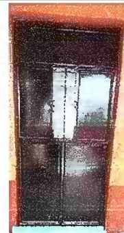
Foto 6: Modulo 2: Mantenimiento a estructura de puerta (aplicación de pinturas)
