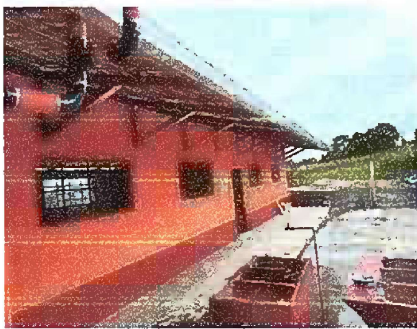
Foto 5: Modulo 1: Sustitución de canal de metal
