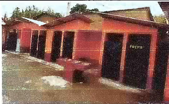
Foto 11: Servicio sanitario: Sustrucción de lamina por lamina troquelada aluzinc calibre 26
