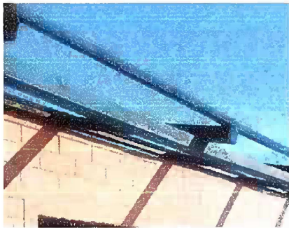
Foto 11: Servicio sanitario: Sustrucción de lamina por lamina troquelada aluzinc calibre 26
