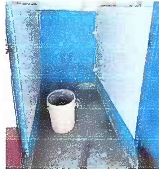
Foto 12: Servicio Sanitario: Sustrucción de piso de torta por piso de granito
