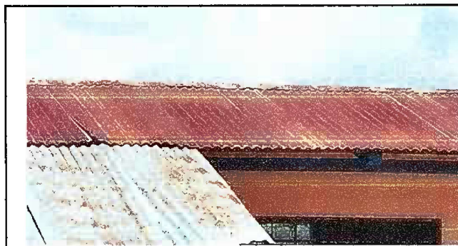
Foto 5: Modulo 1: Sustrución de canal de metal
