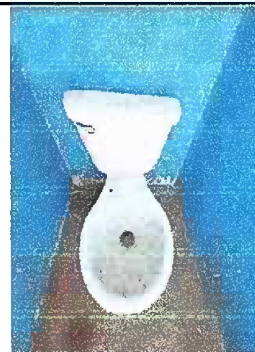
Foto 10: Servicio Sanitario: Sustitucion de inodoro
