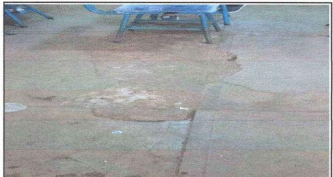
Foto 4: Sustrucción de piso de concreto por cerámica Módulo 1
