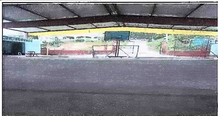
Foto 1: Entrada de la escuela, reparación de plancha de concreto de patio
