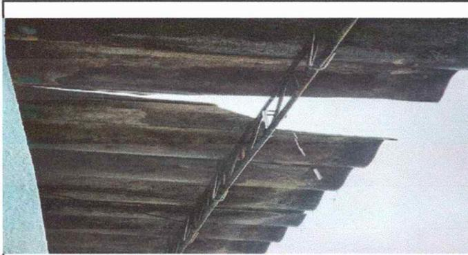
Foto 1: Módulo 1. Sustrucion de soporte de hierro por soporte de metal
