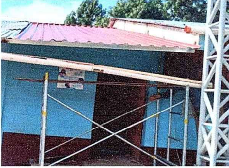
foto 19 modulo 5 sustitucion de laminas por laminas troquelada
