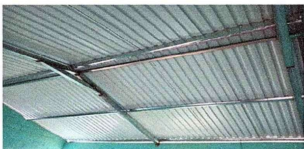
foto 15 modulo 3 sustitucion de soporte de madera por metal
