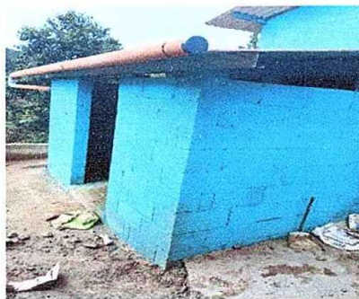
foto 14 modulo 2 reparacion de muro de block
