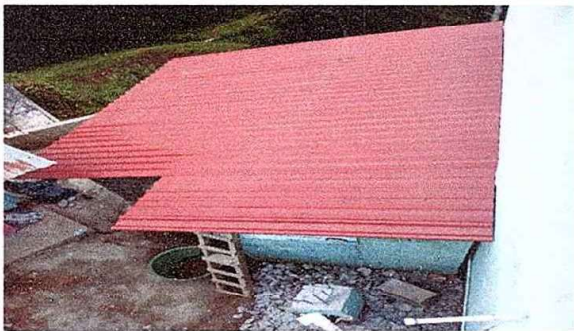
foto 11 modulo 2 sustitucion de laminas por laminas troqueladas
