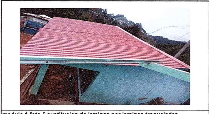
modulo 1 foto 5 sustitucion de laminas por laminas troqueladas
