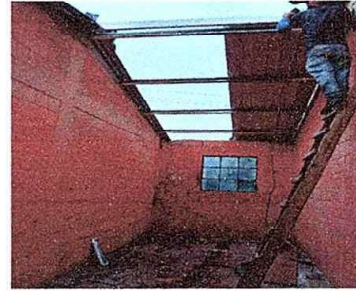
foto 20 modulo 5 sustitucion de costanera por metal
