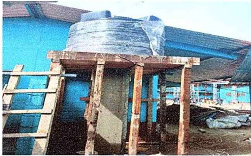
foto 7 modulo 2 sustitucion de deposito de agua 1700lts
