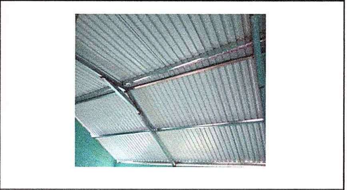
modula 1 foto 4 sustitucion de costanera de madera por metal
