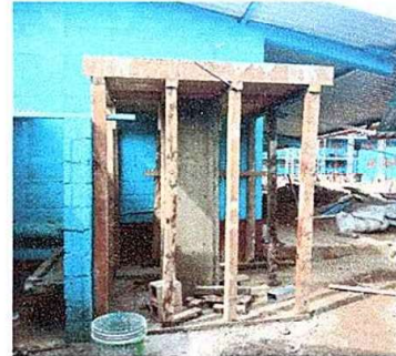
foto 8 modulo 2 sustitucion de base de concreto
