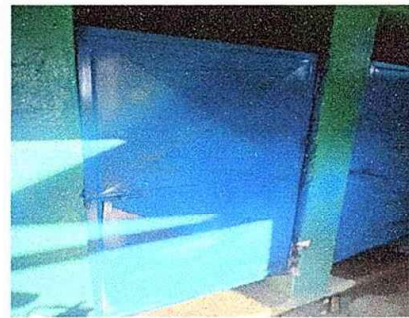
foto 10 modulo 2 suministro de instalacion de puertas de baños
