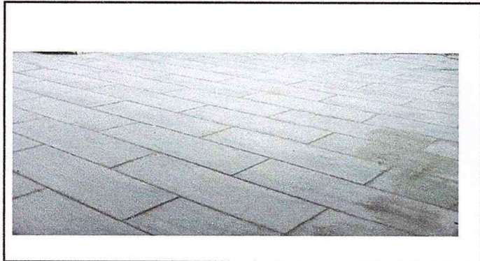
Modulo 1 foto 1 sustitucion de piso de concreto por piso ceramica
