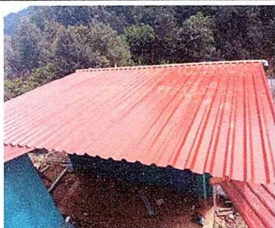
foto 17 modulo 4 sustitucion de laminas por laminas troquelada
