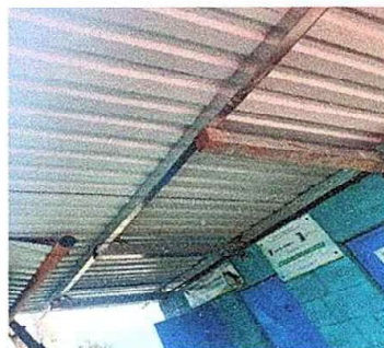
foto 18 modulo 4 sustitucion de costanera de madera por metal
