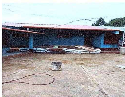
foto 16 modulo 3 sustitucion de laminas por laminas troquelada
