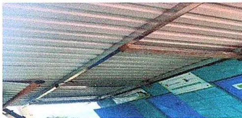
Foto 13: Modulo 4 sustitucion de costanera de madera por metal
