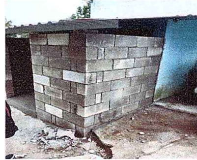
Foto 2: Modulo 2 Reparacion de muro de block
