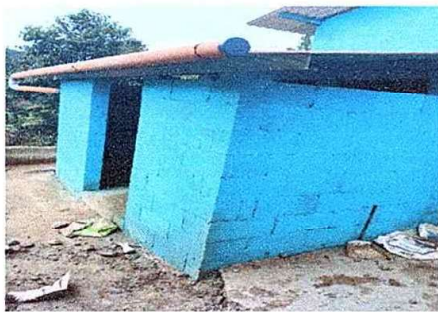
Foto 9: modulo 2 suministro instalacion de puerta
