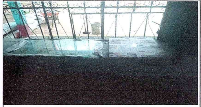
Foto 2: Modulo 1 Sustitucion de vidrios
