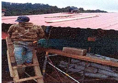
Foto 11: Modulo 2 sustitucion de laminas por laminas troquelada
