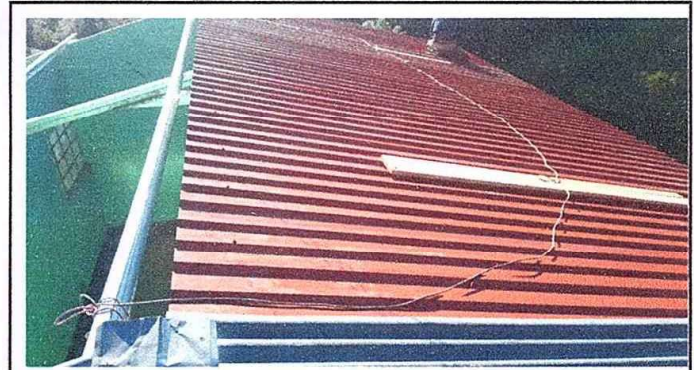
Foto 4: Modulo 1 sustitucion de soporte de madera por metal.
