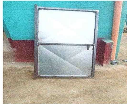
Foto 10: Modulo 2 sustitucion de soporte de madera por metal.
