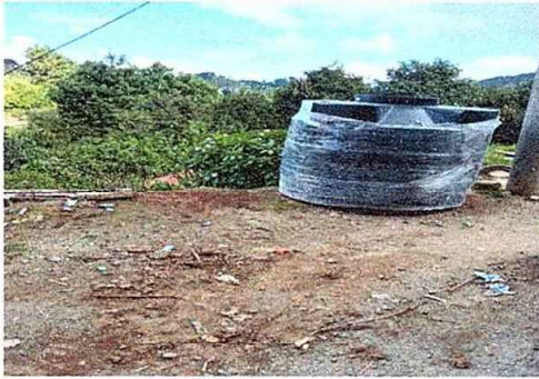
Foto7: Modulo 2 sustitucion de deposito de agua de 1700 lts
