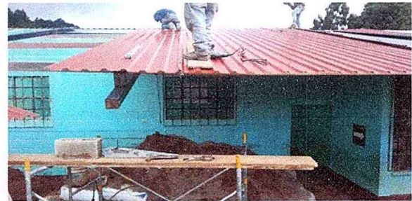
Foto 4: Modulo 3 sustitucion de laminas por laminas troquelada
