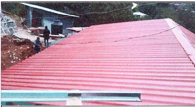
Foto 5: Modulo 1 sustitucion de laminas por laminas troquelada
