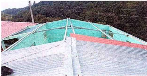
Foto 3: modulo 3 sustitucion de soporte por soporte de metal
