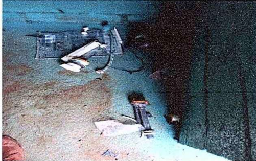
Foto1: Modulo 2 sustitucion de accesorios de inodoro
