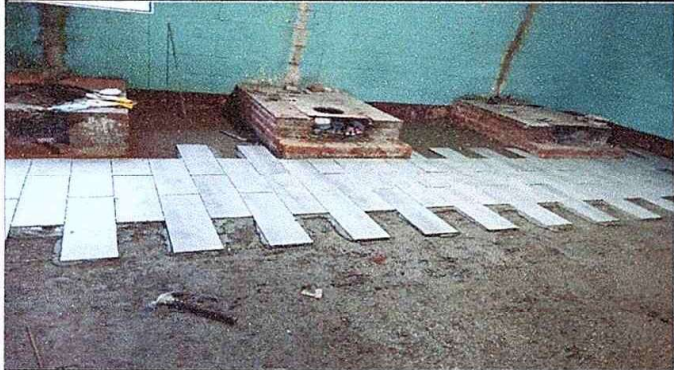
Foto1: Modulo 1 sustitución de piso de concreto por piso de ceramica.
