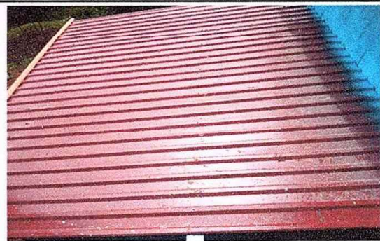
Foto 14: Modulo 4 sustitucion de laminas por laminas troquelada
