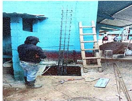
Foto 8 Modulo 2 sustitucion de base de concreto
