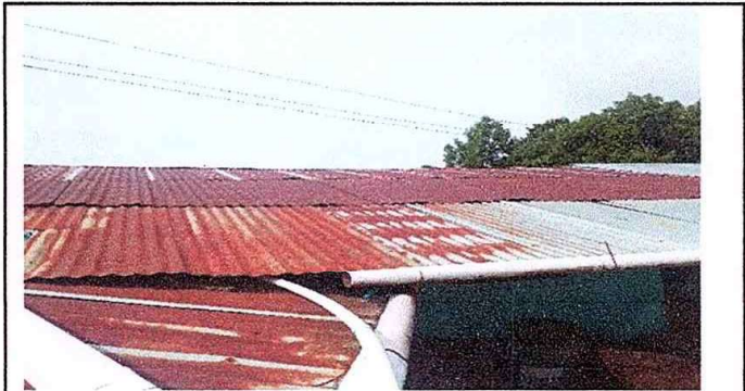
foto 15 Modulo 3 sustitucion de lamina por lamina troquelada
