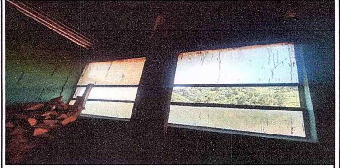
foto 2 Modulo 1. Sustitución de Vidrios.
