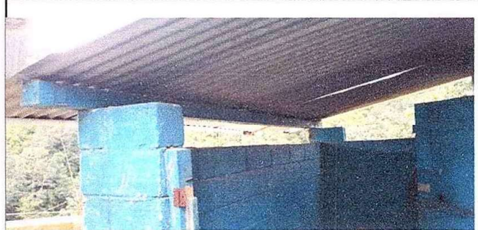
foto 11 Modulo 2 sustitucion de estructura de soporte de madera por metal
