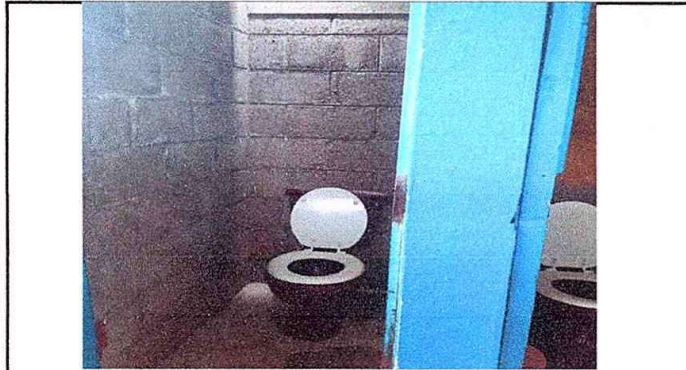
Foto 12 Modulo 2 sustitucion de accesorios de inodoro
