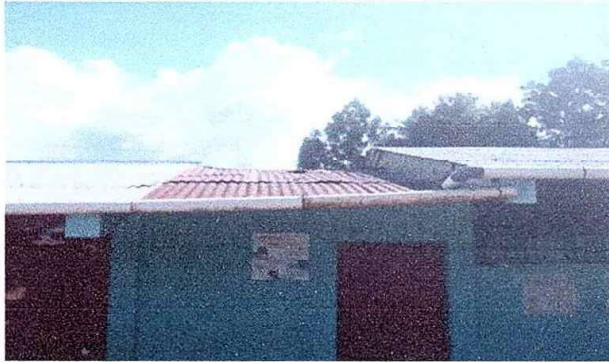
Foto 18 Modulo 5 sustitucion de lamina por lamina troquelada
