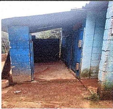
foto 8 Modulo 2 suministro instalacion de puerta
