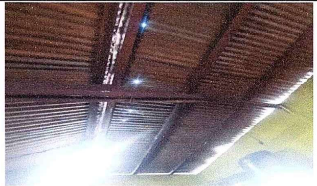
Foto 4 Modulo 1 Sustitución de soporte de madera por metal.
