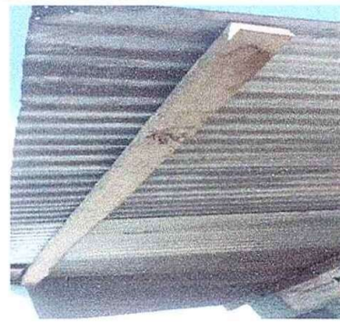
Foto 19 Modulo 5 sustitucion de madera por metal
