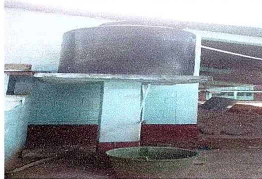
foto 7 Modulo 2 Sustitucion de base de concreto
