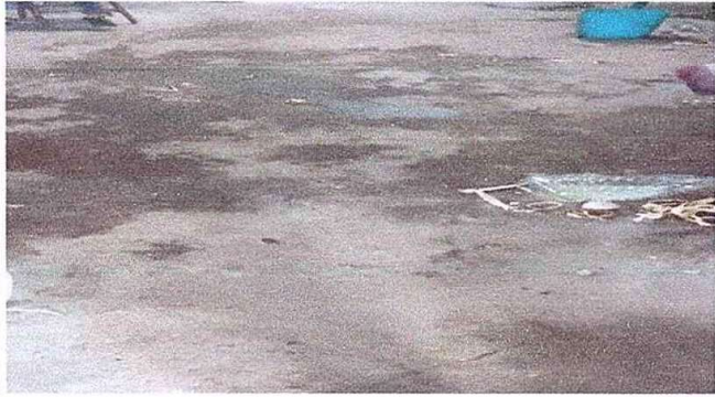
Foto 1 Modulo 1 Sustitución de piso de concreto por piso ceramica.
