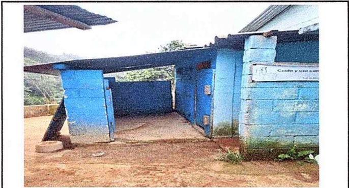
Foto 13 Modulo 2 Reparacion de muro de block.
