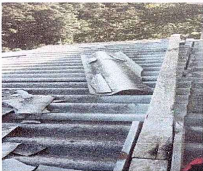
foto 10 Modulo 2 sustitucion de lamina por lamina troquelada.
