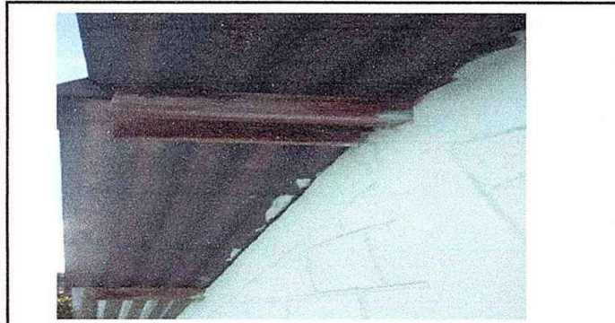
foto 14 Modulo 3 sustitucion de soporte madera por metal
