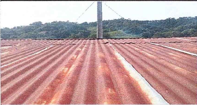
Foto 4 Modulo 1 Sustitución de láminas por láminas troquelada.
