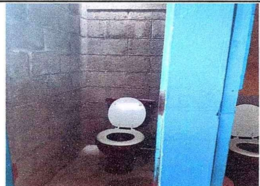
foto 9 Modulo 2 suministro instalacion de puerta de baños
