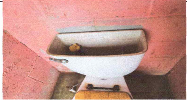
Foto 4: Módulo 2. Sustitución de inodoros
