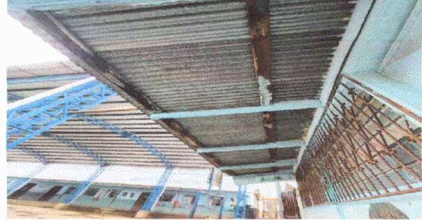
Foto 2: Módulo 1. Sustitución de láminas acanaladas por láminas troquelada
