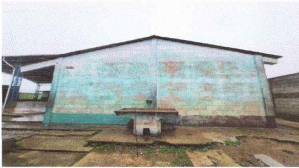
Foto 3: Módulo 1 Pintura para paredes interior y exterior
