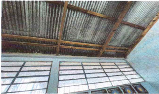
Foto1: Módulo 1. Sustitucion de soporte de madera por soporte de metal
