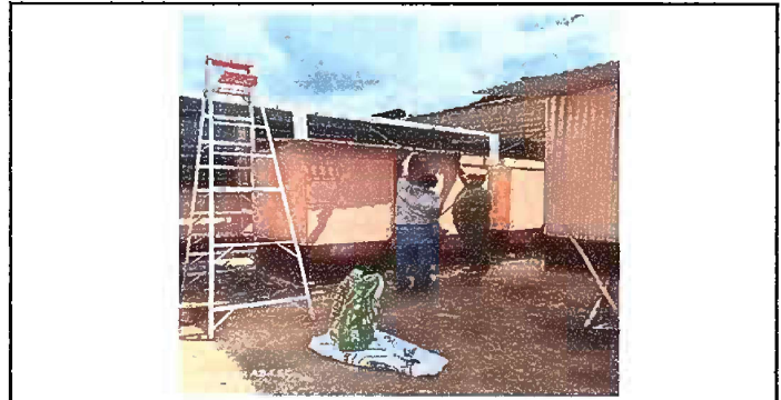
Foto 4: Módulo 4, sustitución de lámina por lámina troquelada aluzinc cal. 26.
